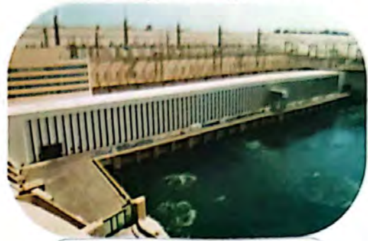
محطة كهرباء السد العالي
